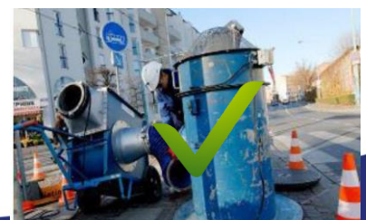
Exemple d'installation d'un système de ventilation avant intervention dans les réseaux d'assainissement (source INRS)
