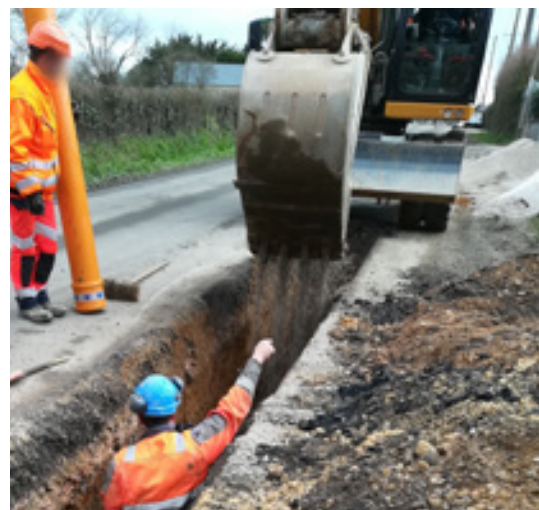
Réalisation d'une tranchée
