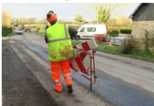
Mise en place de signalisation temporaire
