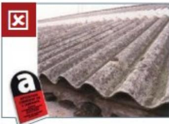
On entend par **matériaux fragiles**, les diverses plaques planes, ondulées ou nervurées, les **matériaux translucides** (lanterneaux ou skydômes) réalisés en :
